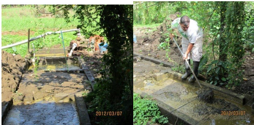
Tanques de recolección de residuos y motobomba.
