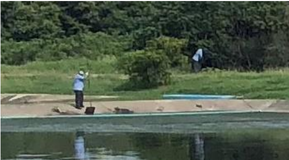
Fotografía 7. Personal de AyA realizando labores de extracción de natas en un sector de la superficie de una de las lagunas.
