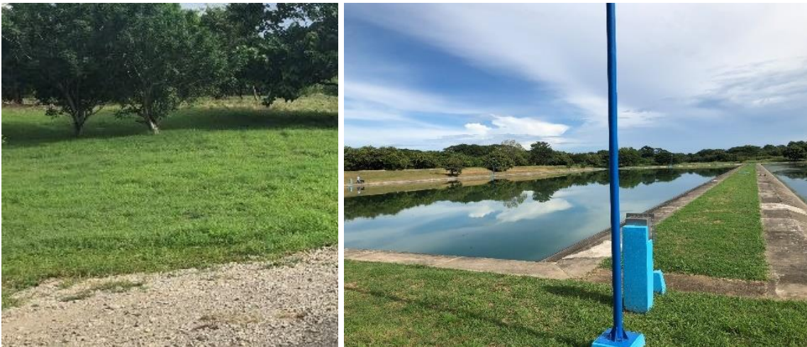
Fotografías 1 y 2. Condiciones del predio en el cual se ubican las dos primeras lagunas facultativas.
