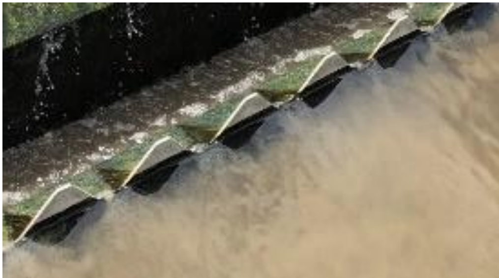
Fotografía 10. Arrastre de lodos a la salida del reactor secundario a la hora de la visita.
