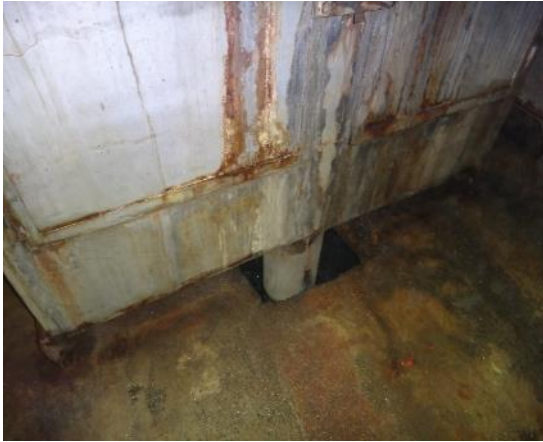
Fotografía 6 y 7. Corrosión y arenas producto del pretratamiento de las aguas residuales.
