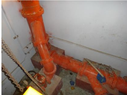
Fotografía 3 y 4. Problemas de corrosión en el emisario submarino.
