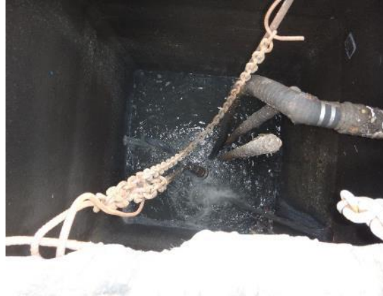
Fotografía 8 y 9. Camión hidrovaciador y colector de aguas residuales obstruido.
