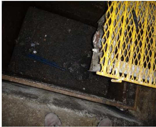
Fotografía 6 y 7. Corrosión y arenas producto del pretratamiento de las aguas residuales.
