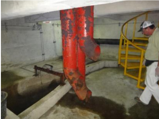
Fotografía 3 y 4. Problemas de corrosión en el emisario submarino.
