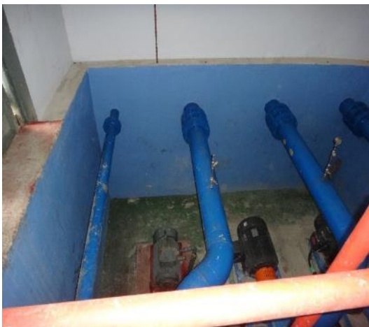
Fotografía 3 y 4. Sistema de bombeo para propulsión del agua hacia el mar y área de ingreso
